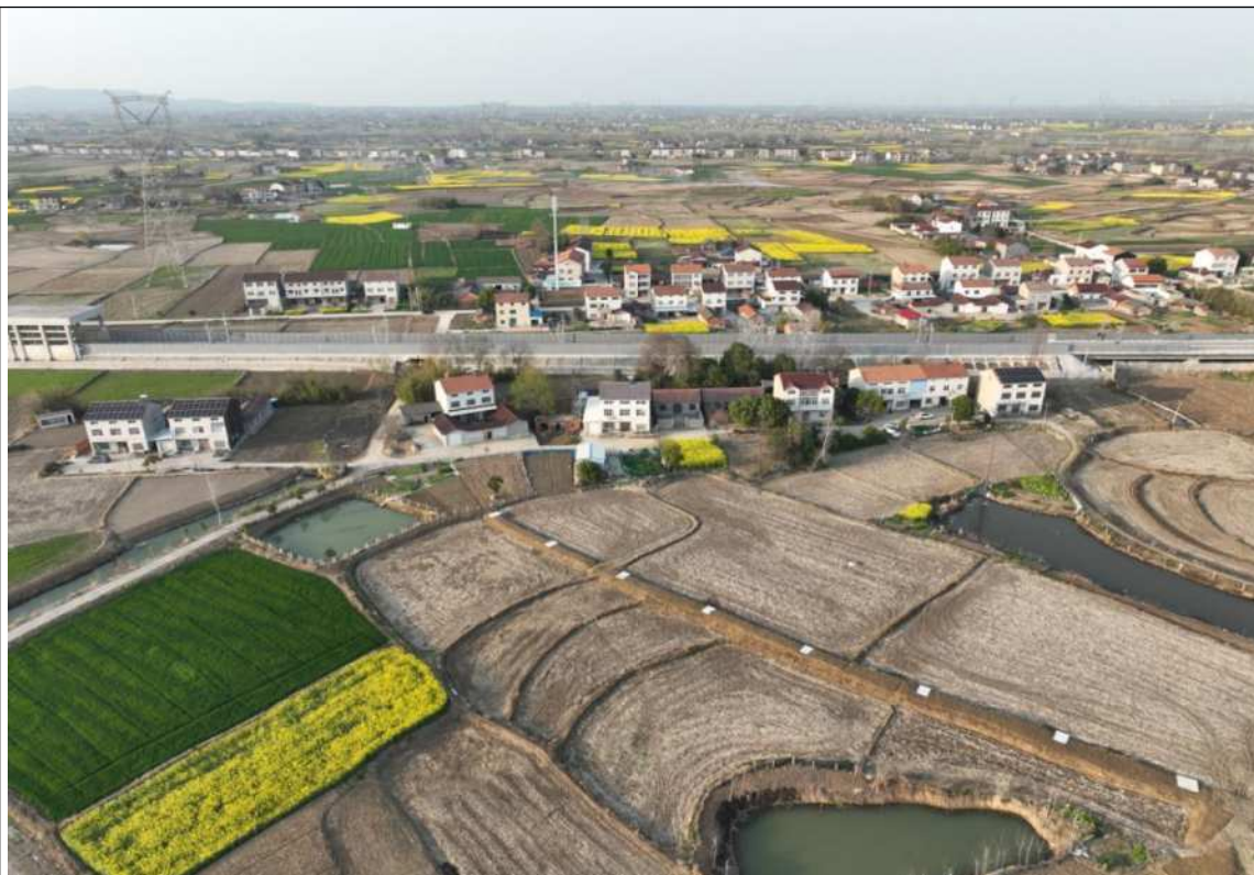
铁岗村 6 组、7 组（左侧）声屏障设置位置航拍/照片
