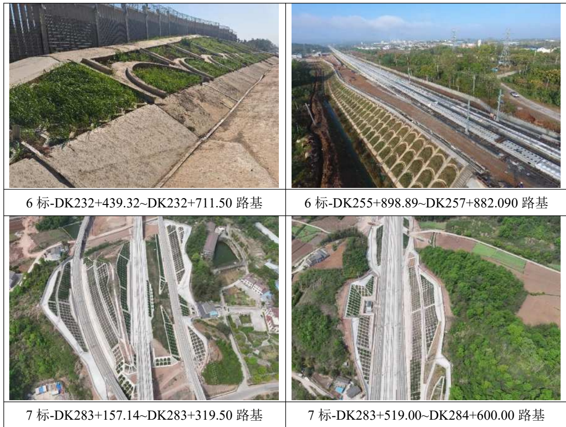
图 6.4-1 路基、路堑边坡绿化现场照片
