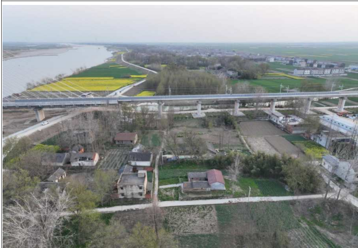
万伏村一组声屏障设置位置航拍/照片
