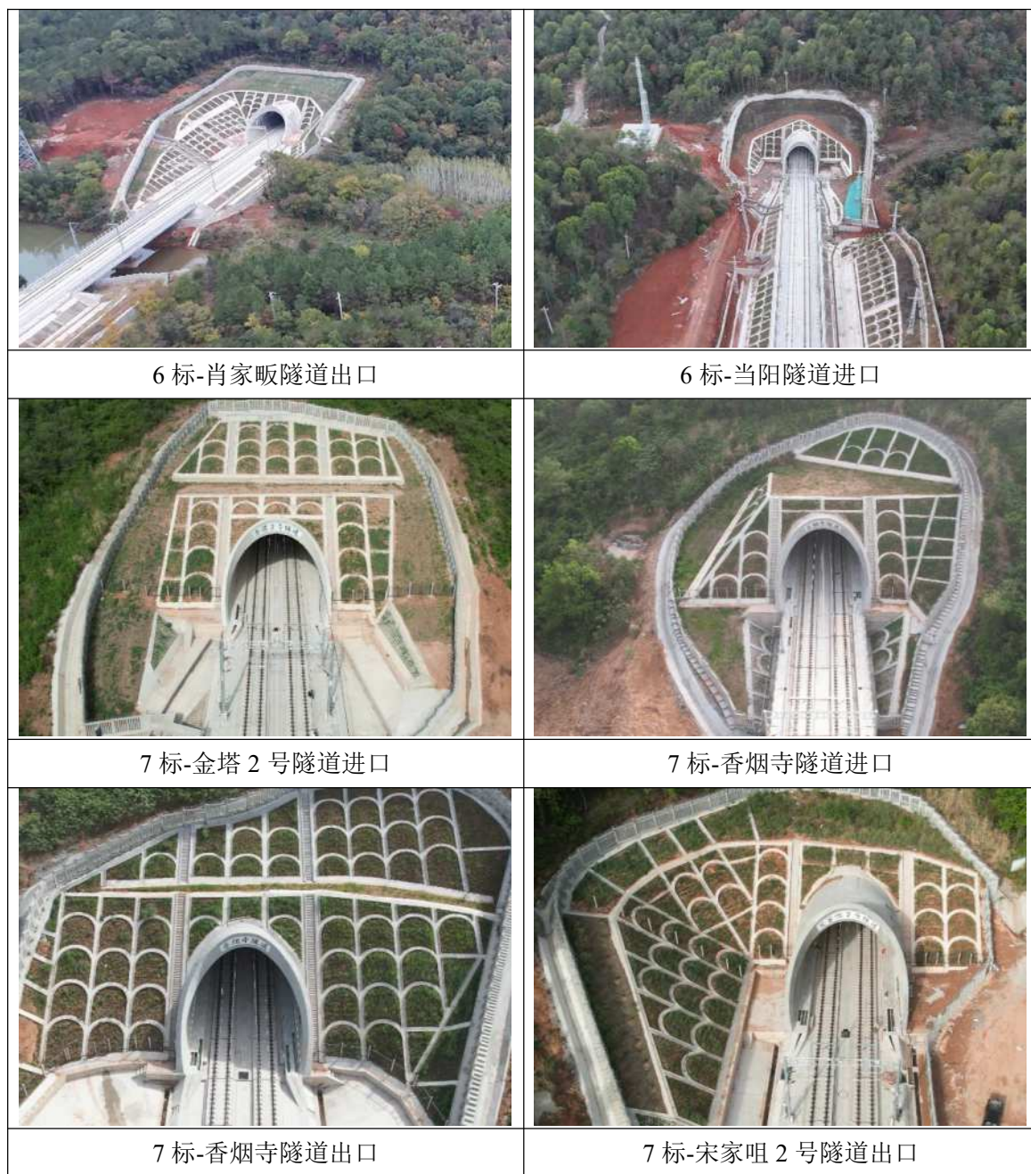
图 6.4-3 隧道洞口防护及绿化照片
