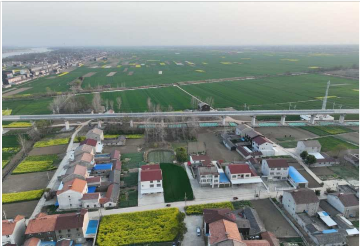
万伏村四组声屏障设置位置航拍/照片
