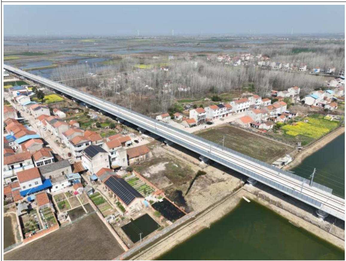
窑场村声屏障设置位置（双侧）航拍/照片
