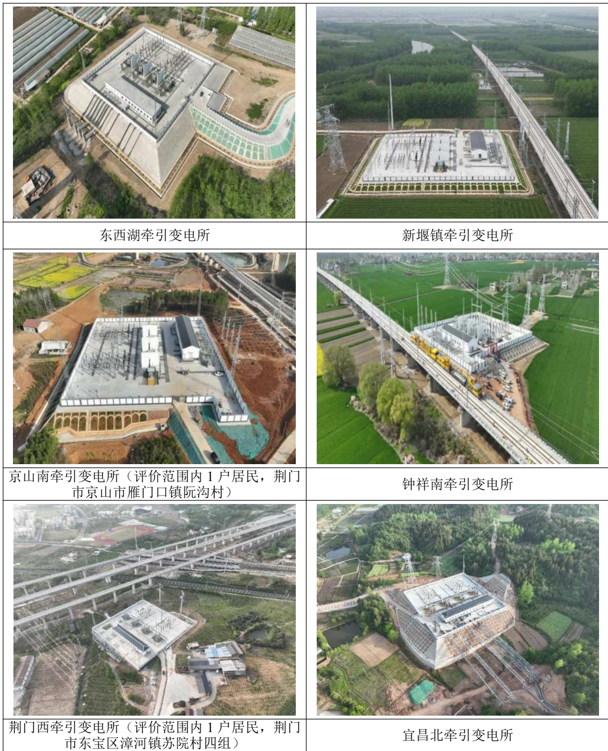
图 10.3-1 牵引变电所及周边现状照片
