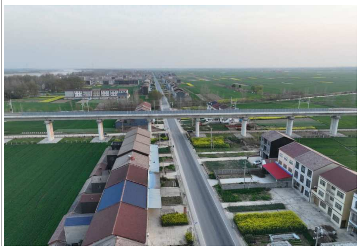
万伏村四组声屏障设置位置航拍/照片
