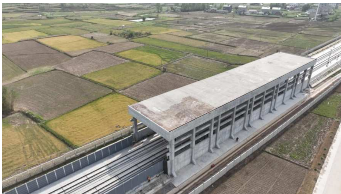
声屏障与防护棚架设置位置航拍/照片
