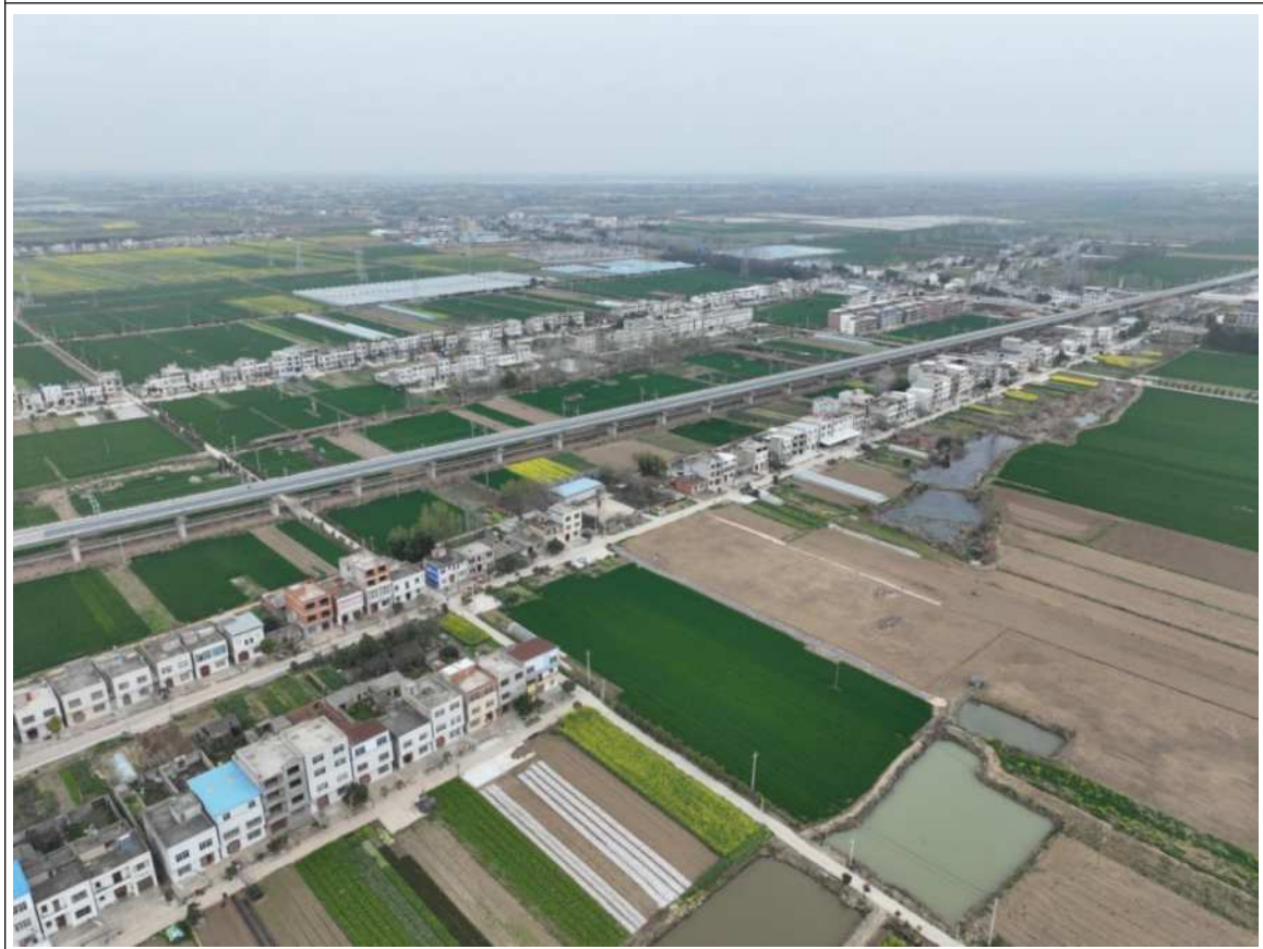
马家湾、熊家湾、风家湾村声屏障设置位置航拍/照片
