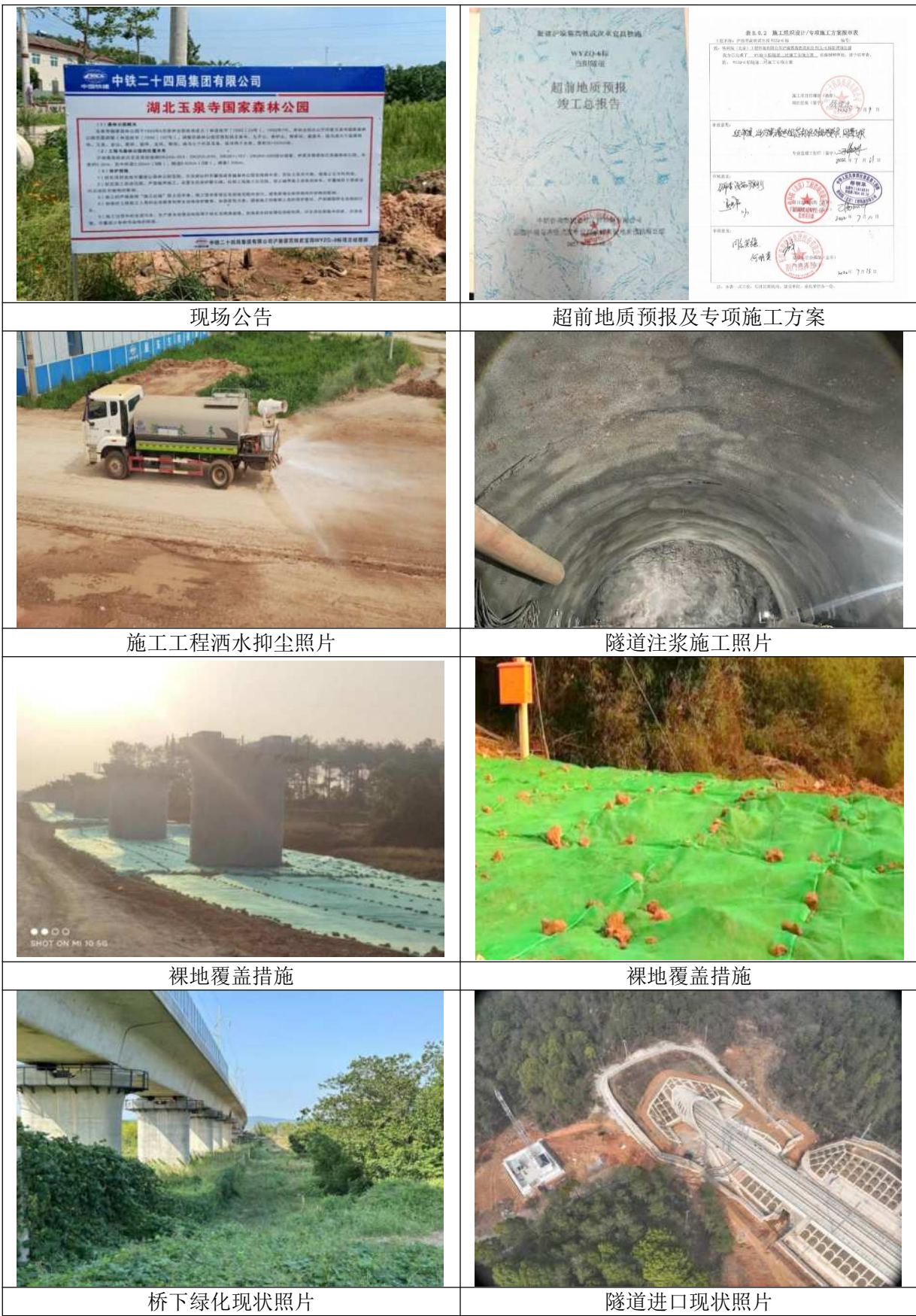
图 6.2-10 环保措施落实情况照片
