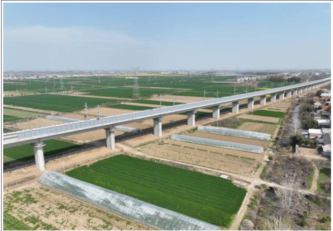
中岭村、新袁家台声屏障设置位置航拍/照片
